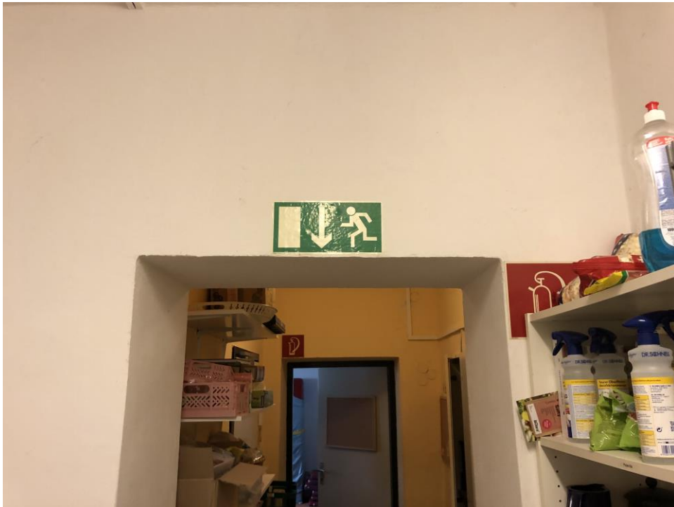
Bild 2: Durchgang Küche in Richtung Gang
